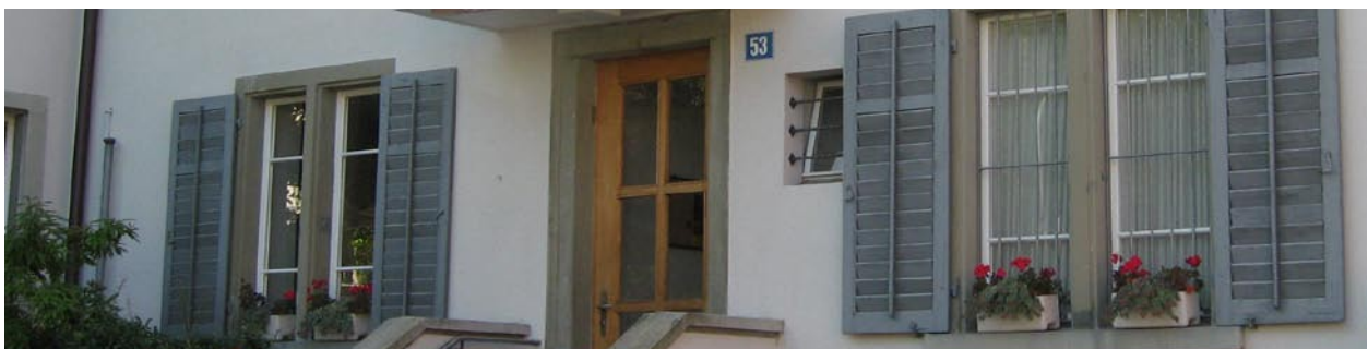
Familien- und Generationenhaus «Sonnegg» – Reformierte Kirchgemeinde Zürich-Höngg
